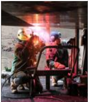
Les coques trop fatiguées sont renforcées avec de grandes plaques d'acier.
